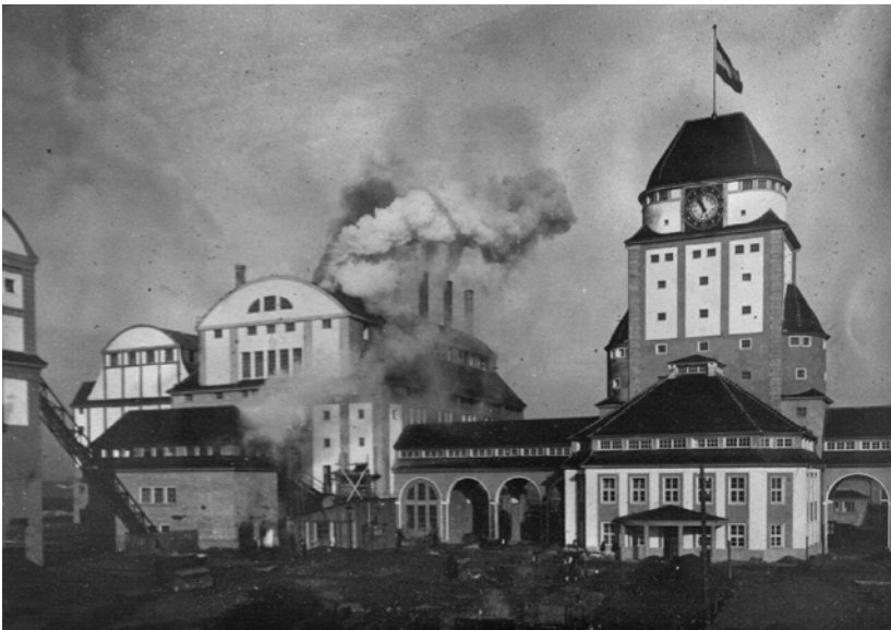
Ofenhaus und Behälterturm um 1920, Quelle: Gaswerksfreunde Augsburg, Oliver Frühschütz
